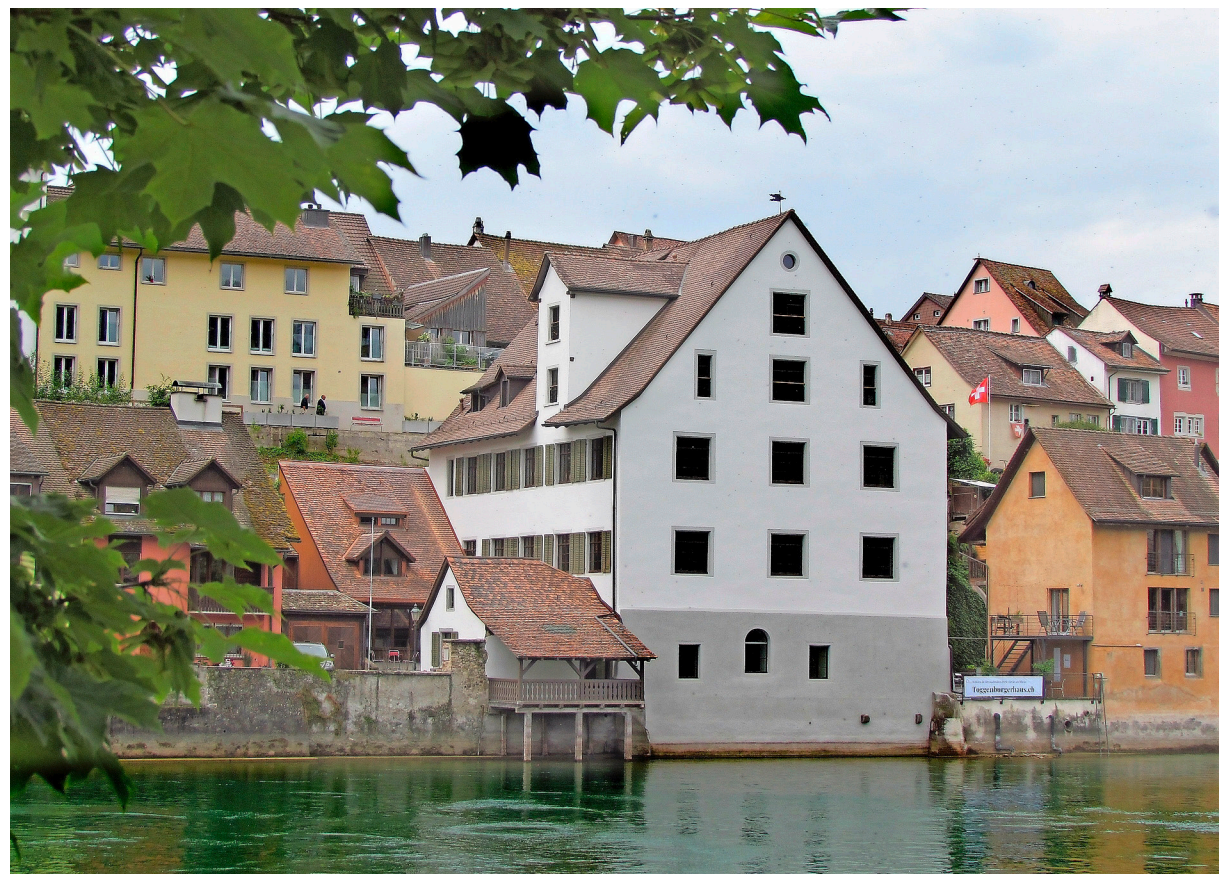
Das Toggenburgerhaus wurde während 15 Monaten aufwendig saniert.
